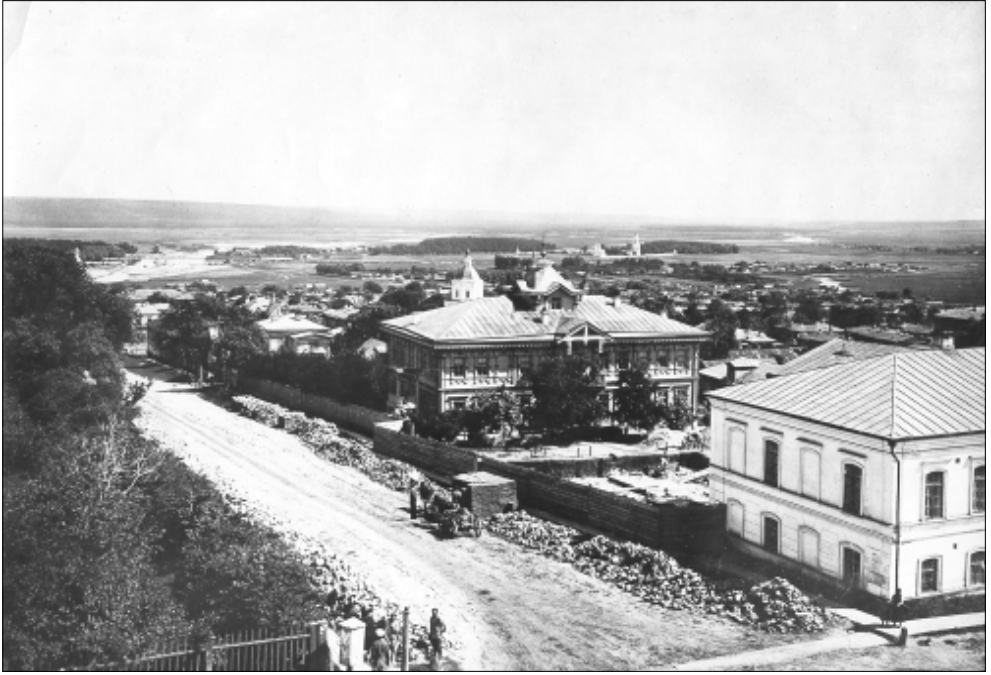
Строительство нового здания Пензенского духовного училища
