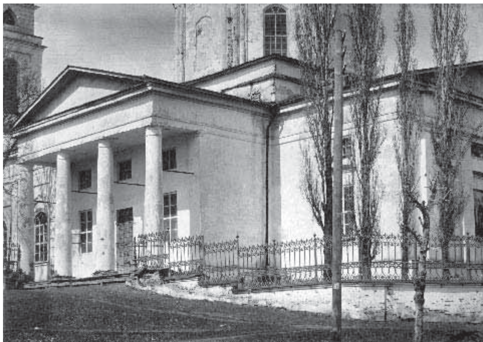
Никольская церковь в аварийном состоянии. 1920-е гг. Фото из коллекции И. Шишкина
